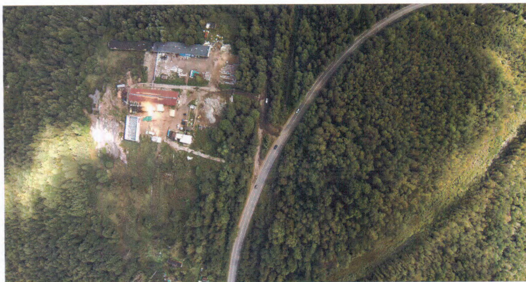
Рисунок 2.6 – Строительная база, Тестовый участок № 7, 60°03'44" N, 31°01'40" E Всеволожский район.
